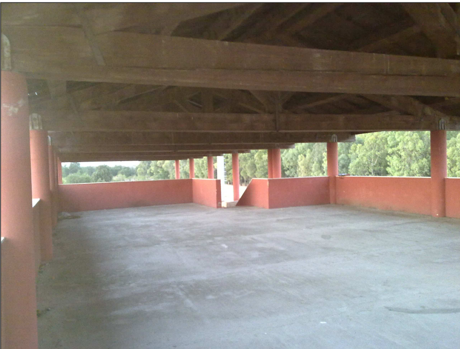
Foto 4 – vista del terrazzo dove realizzare il bat-roost, con la scala di accesso
