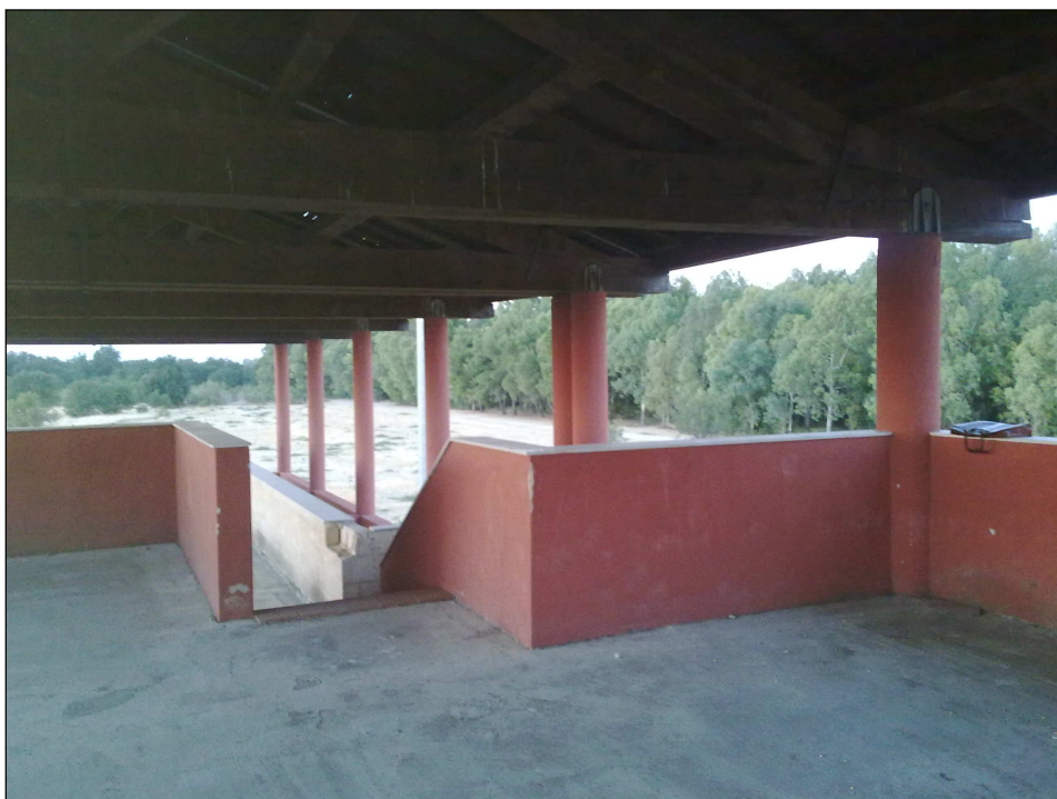
Foto 6 – scala di accesso al terrazzo dove realizzare il bat-roost
