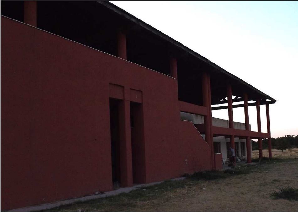
Foto 3 – vista laterale del fabbricato dove realizzare il bat-roost
