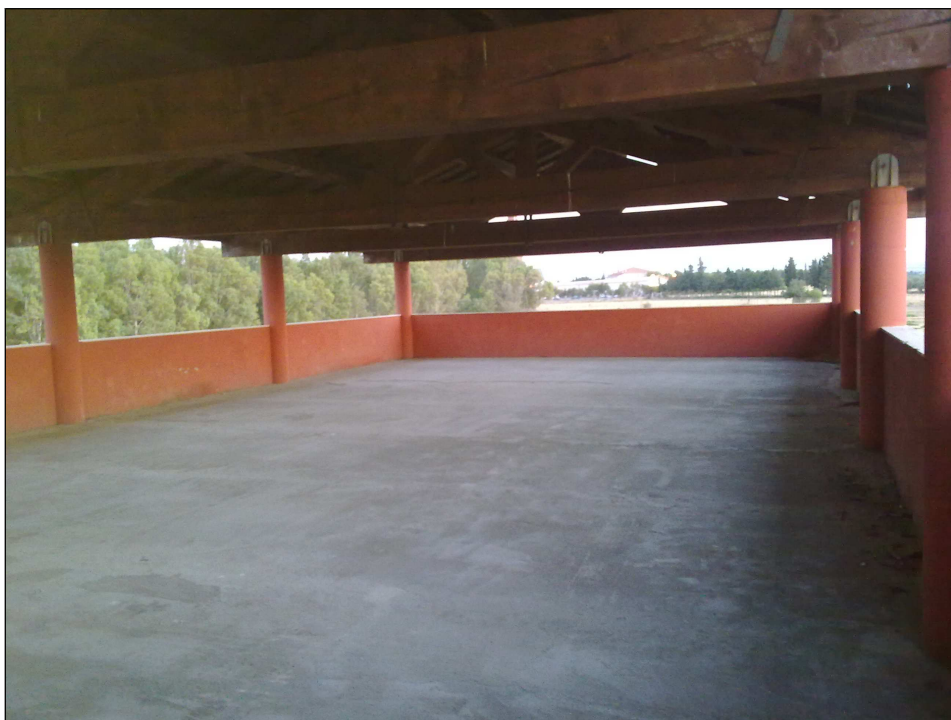
Foto 5 – vista del terrazzo dove realizzare il bat-roost
